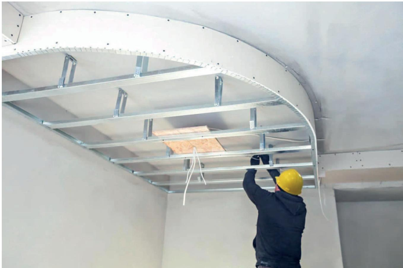
Asma örtginiň karkasy / Suspended ceiling frame / Каркас подвесного потолка
